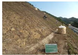
法面清掃 除草 2段目
