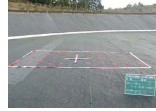
アンカー確認
