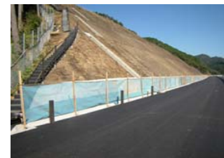
法面清掃完了
