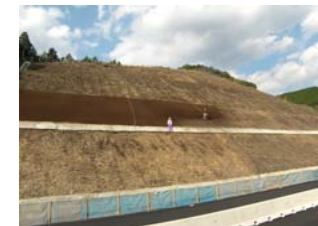
吹付状況 2段目
