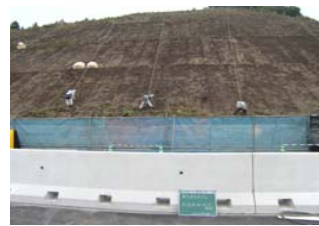
法面清掃 除草 1段目
