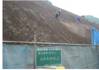
法面清掃 エアー清掃 1段目
