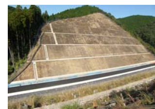
法面清掃完了
