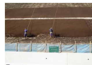
吹付状況 1段目
