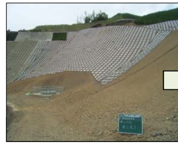
法枠組立完了
