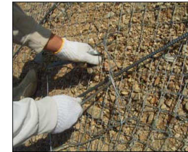
ガッテンダー設置
